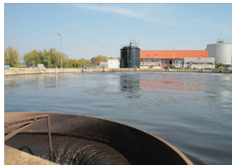
Auch wenn die Kläranlage Hillersleben in Sachen Nachhaltigkeit ein Vorbild für andere Verbände sein kann, zeigt die Benchmarking-Studie weitere Potenziale für eine zukunftsweisende Energieversorgung der Anlagen auf.
