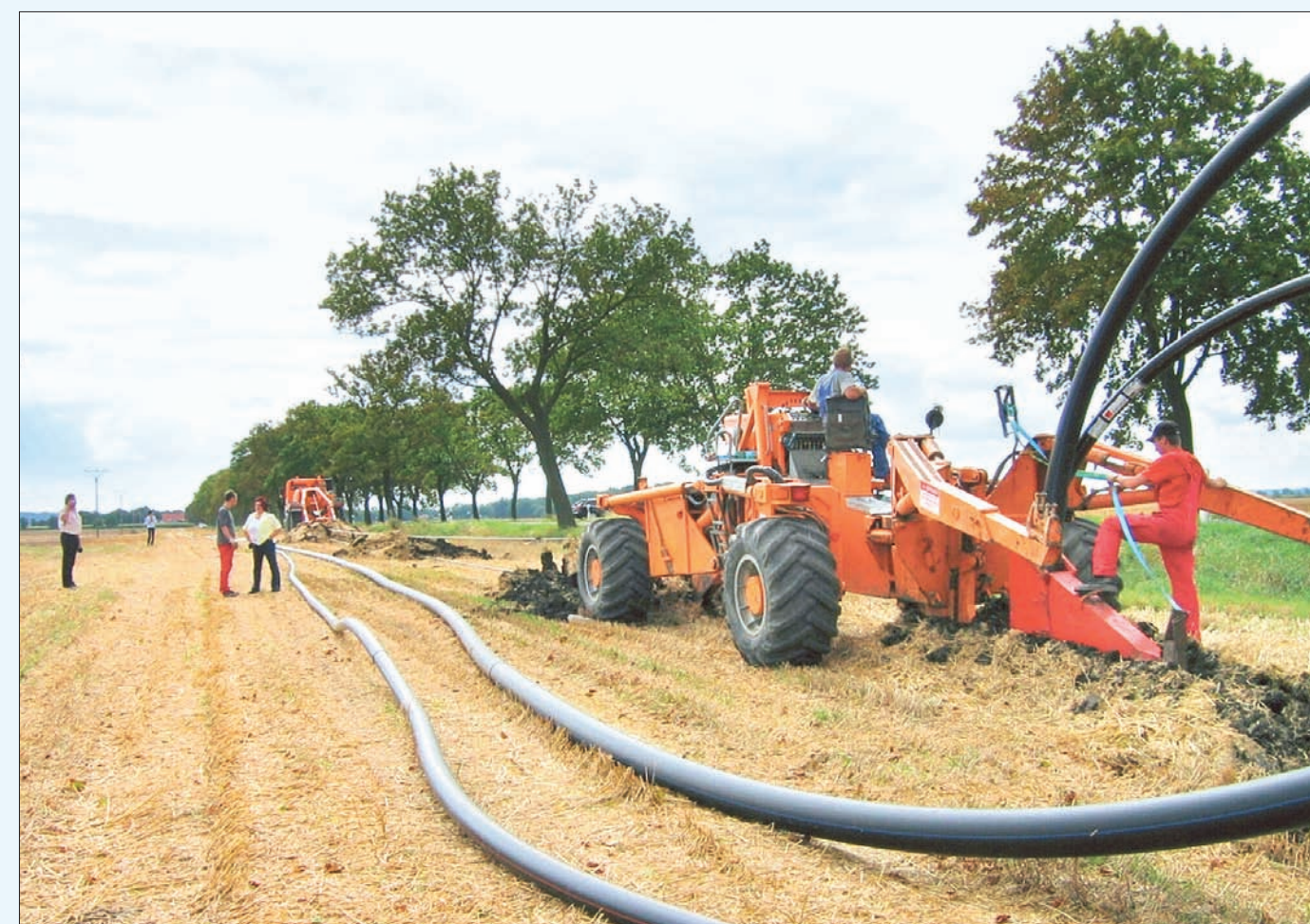
Der Rohrflug, ein Spezialflug zum Verlegen von Leitungen, im Einsatz auf einem privaten Grundstück.
