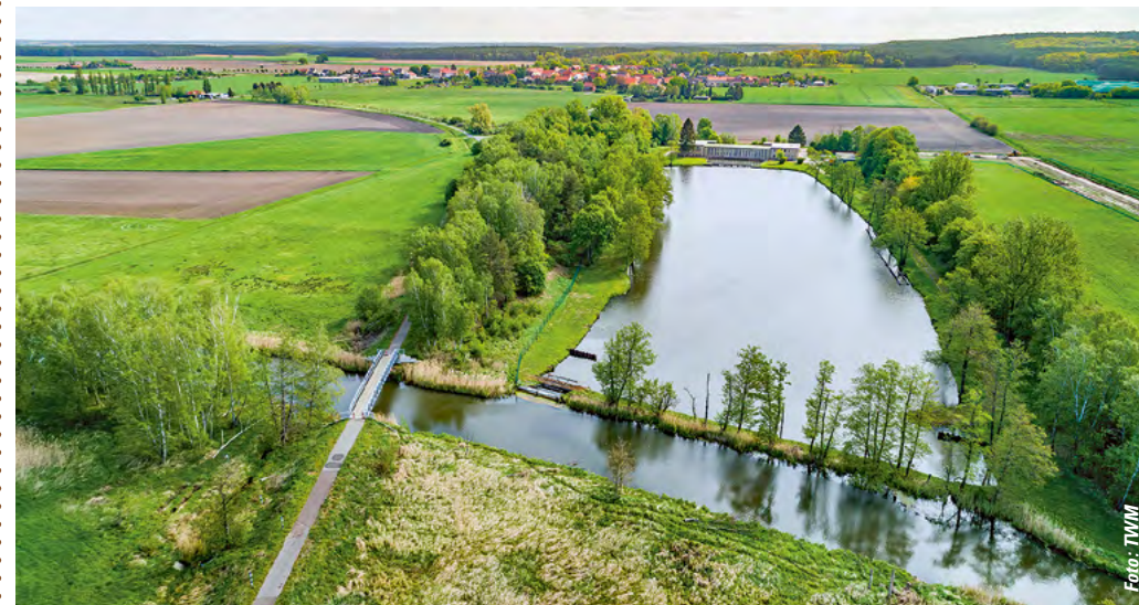
Einlaufbauwerk und Entnahmebecken an der Ohre. Im Hintergrund ist das Pumpwerk Satuelle zu sehen.
